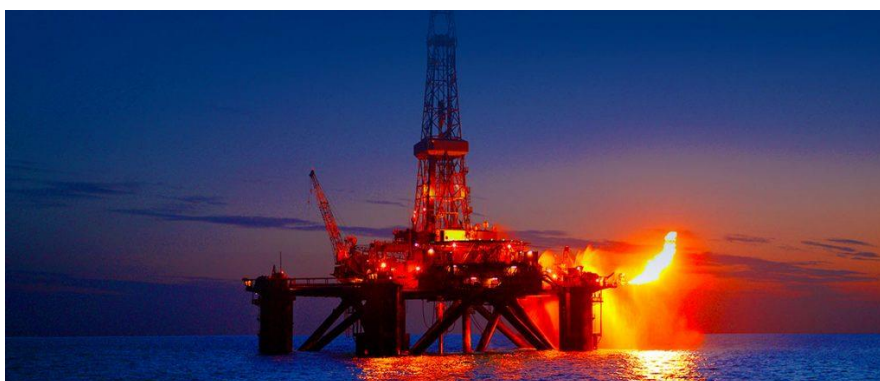
Figura 27 – Plataforma da Petrobras.
