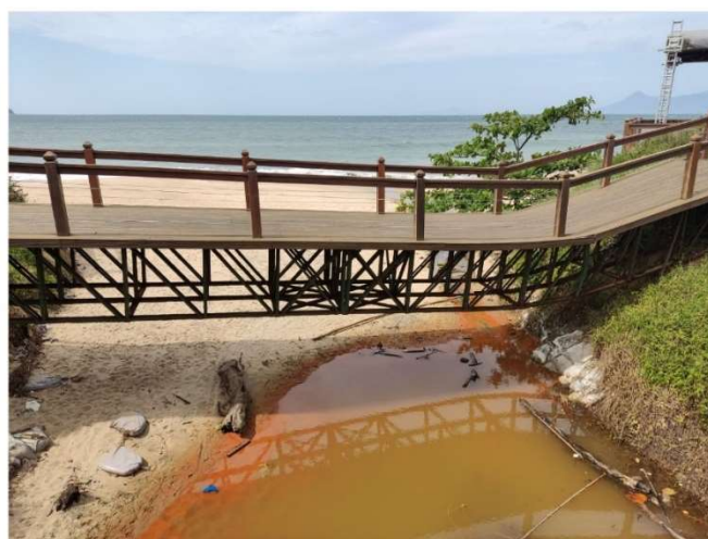
Canal de drenagem que deságua no mar, abril 2022.
