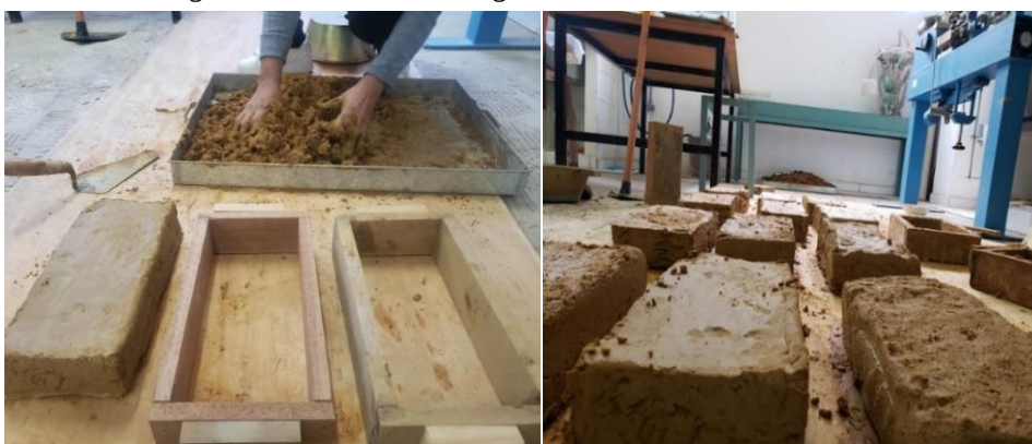
Figura 17 - Mistura e moldagem dos blocos de adobe
