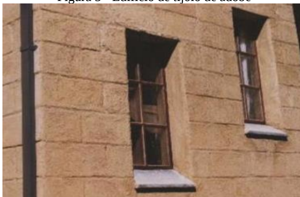
Figura 3 - Edifício de tijolo de adobe
