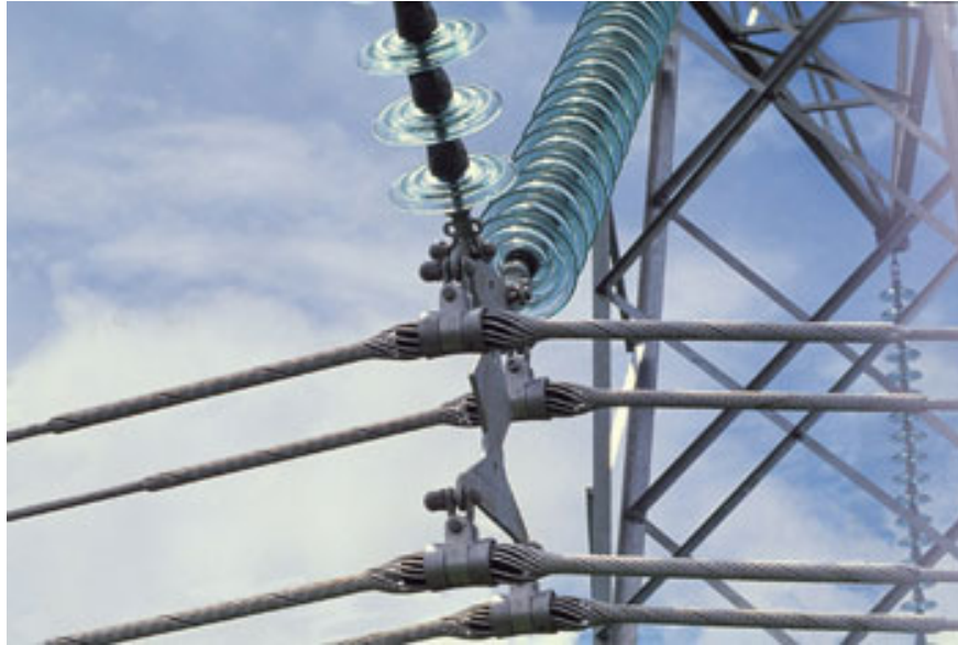
Figura 1.4 – Condutor múltiplo composto por quatro subcondutores.
