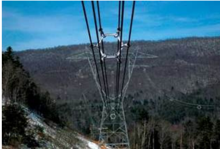
Figura 1.5 – Condutor múltiplo composto por seis subcondutores.
