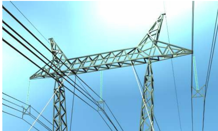
Figura 1.6 – Linha de transmissão com potencial naturalmente elevado (condutores múltiplos assimétricos).
