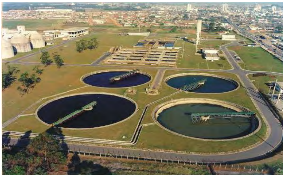
Figura 15: Decantadores primários – ETE Suzano, em SP Fonte: Von Sperling (2006)
