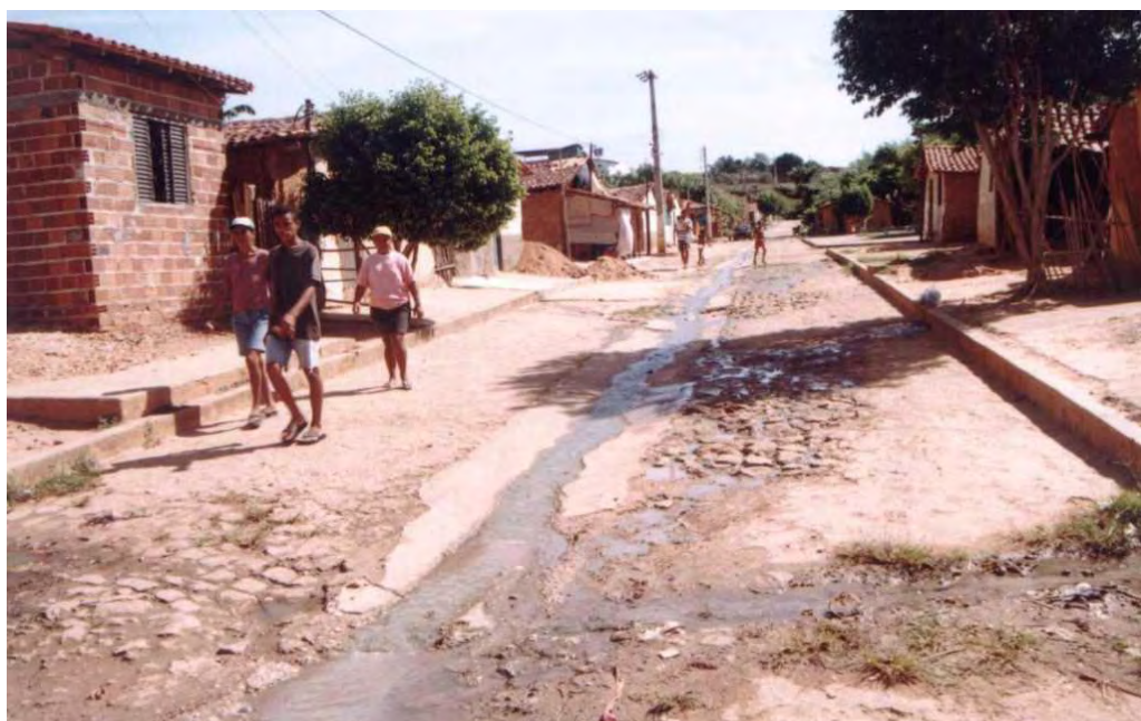
Figura 33: Esgoto bruto escoando a céu aberto no bairro Satélite, Zona Leste. Fonte: Prof. Carlos Gomes Correia Lima (2004).
