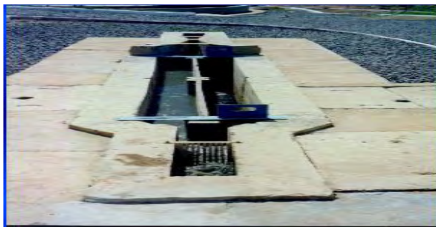
Figura 14: Tratamento preliminar: grade, caixas de areia e calha Parshall. Fonte: Von Sperling (2006)
