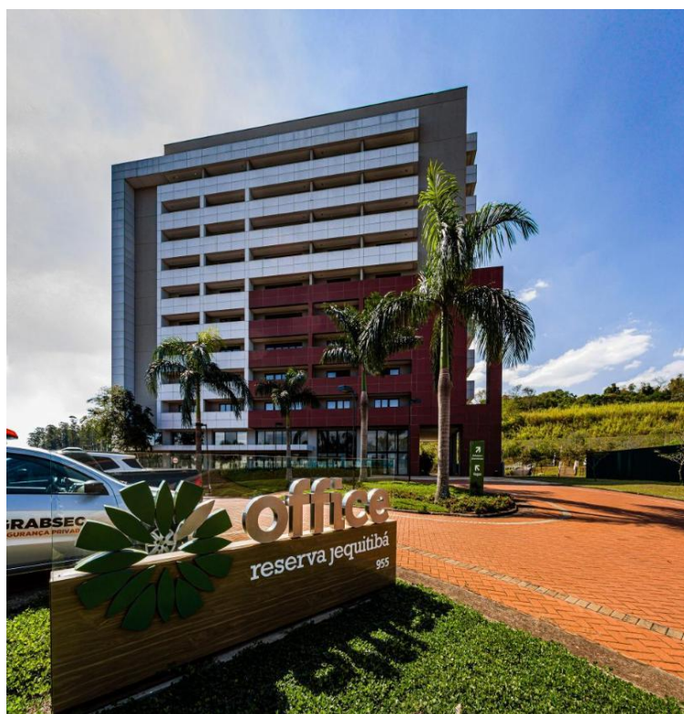
Foto 2: Vista da fachada de entrada do Office Reserva Jequitibá
