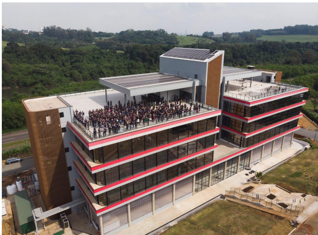
Foto 5: Prédio PECEGE no PTP
