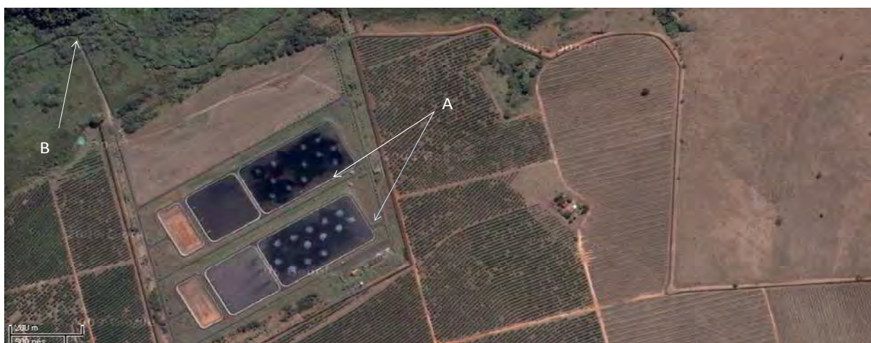
Figura 16: Estação de tratamento de esgoto de Araraquara. (A) indica as lagoas de tratamento e (B) indica o ponto de despejo do efluente no Ribeirão das Cruzes, local onde é realizada as coletas de efluentes de ETE.
