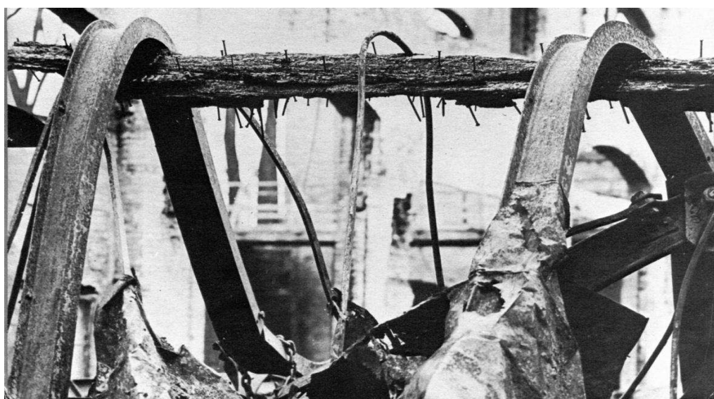
Figura 5 - Viga de madeira sustentando estrutura metálica.
