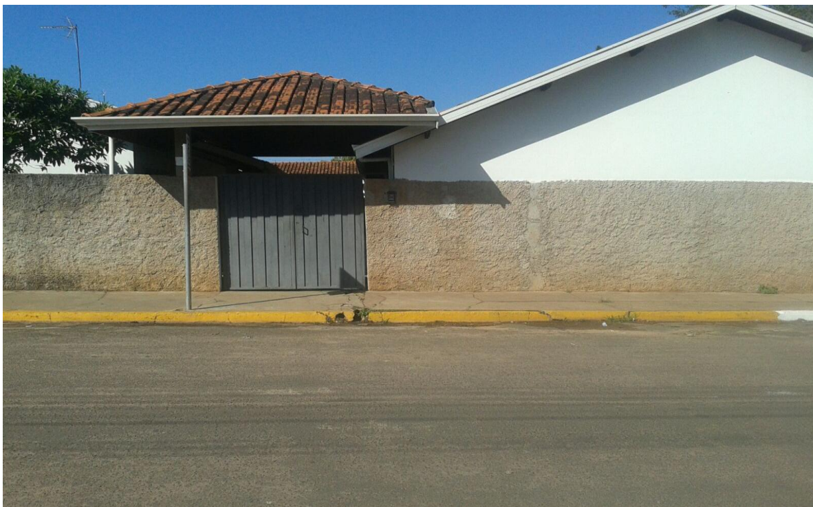
Figura 1: Entrada da Escola 2 – Lado A Fonte: Arquivo da pesquisadora
