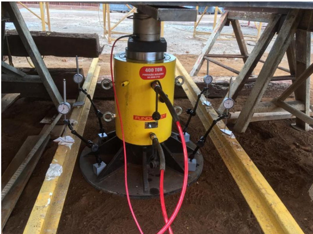
Figura 10 – Prova de carga direta em placa.
