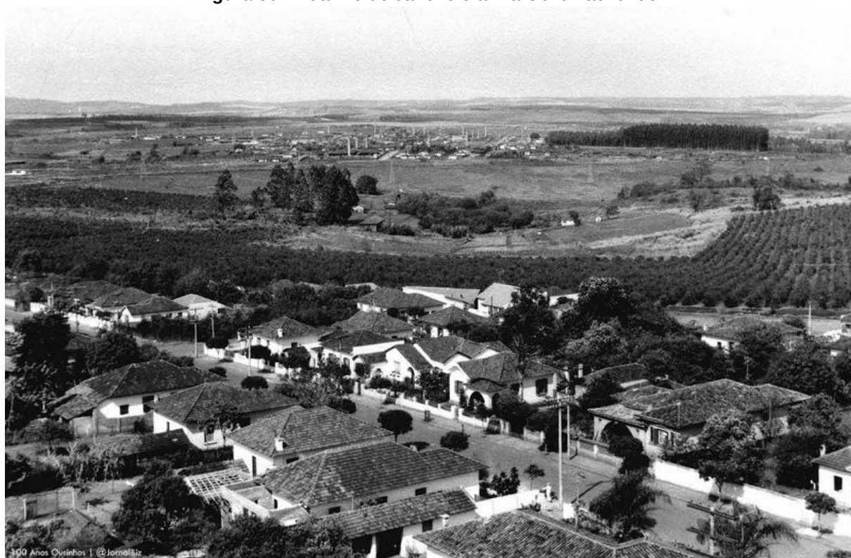
Figura 80 - Rua Rio de Janeiro e a vila Odilon ao fundo
