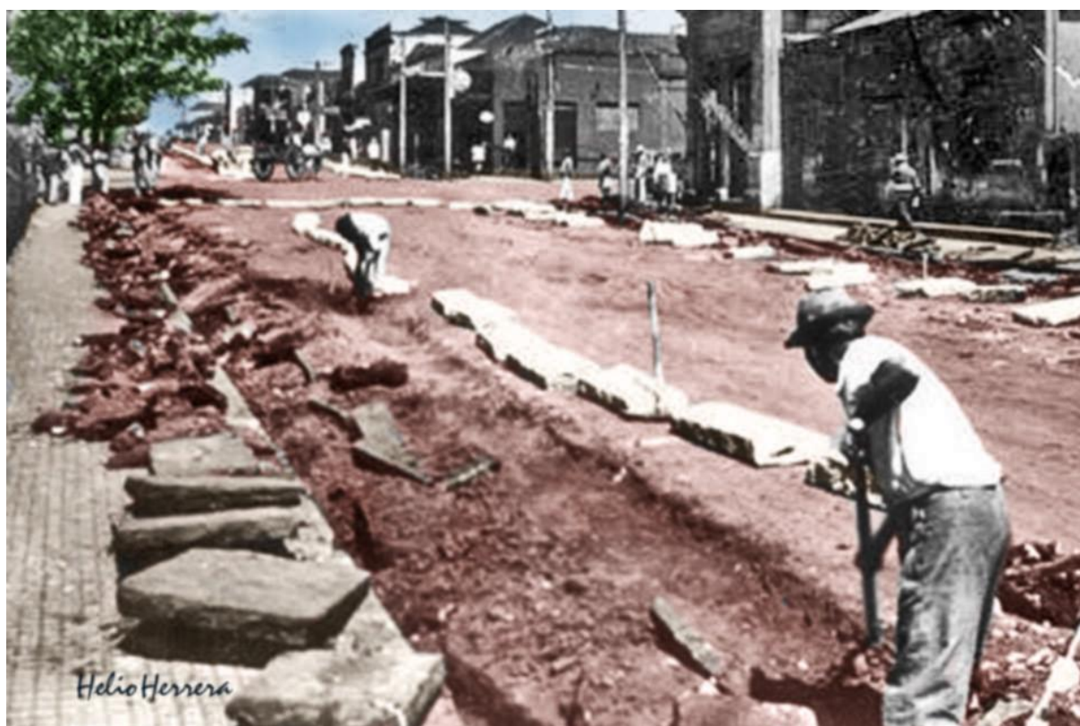
Figura 72 - Início do Processo de Colocação das Sarjetas nas Vias de Assis
