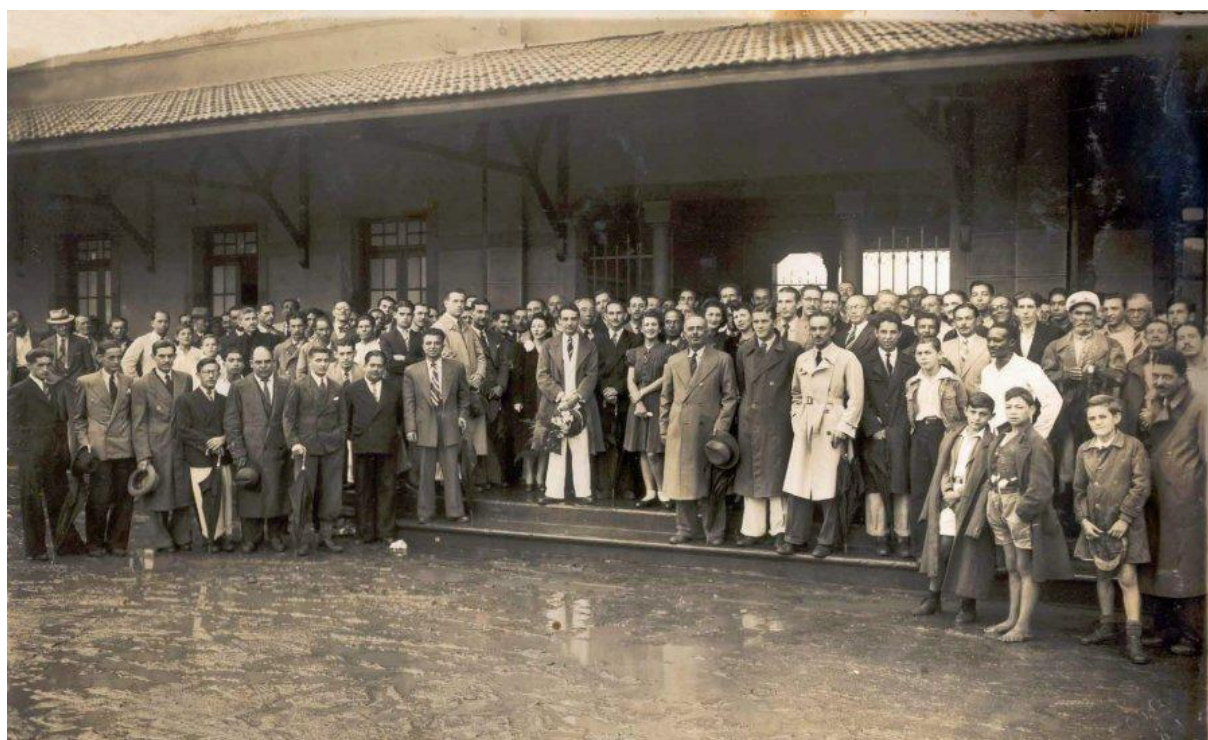
Figura 56 - Vista da Estação Ferroviária de Ourinhos
