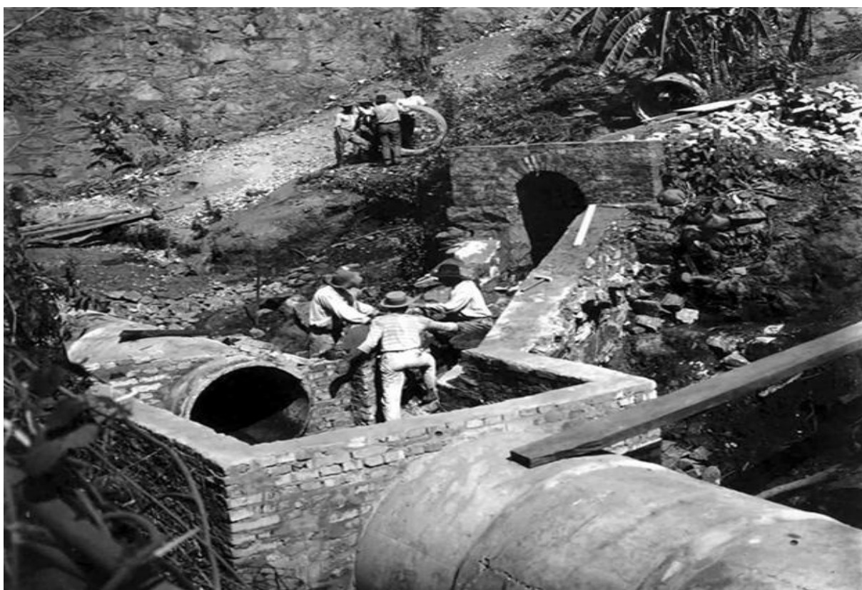
Figura 76 - Obras de Drenagem Urbana em Assis
