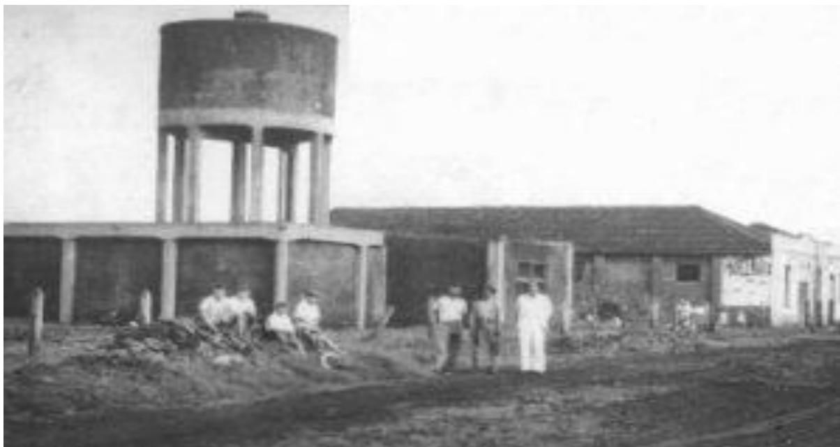
Figura 75 - Antigos reservatórios para distribuição situados na Av. Altino Arantes (atual sede da SAE)
