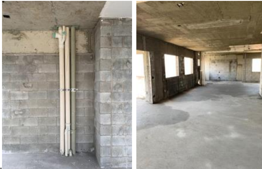
Figura 21 - Prumadas hidráulicas fixadas e chumbadas (esquerda); contramarcos posicionados, chumbados e contrapiso executado (direita).
