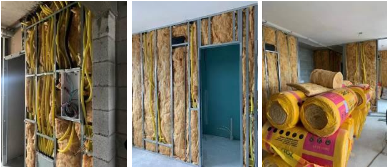
Figura 37 - Colocação da lã de vidro após a primeira etapa de plaqueamento e rolos de lã de vidro utilizados na etapa de isolamento acústico do Sistema Drywall .
