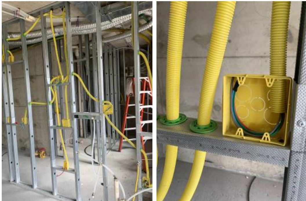
Figura 28 - Cadeirinhas para fixação das caixas elétricas na estrutura (esquerda); detalhe da caixa elétrica fixada no suporte metálico (direita).
