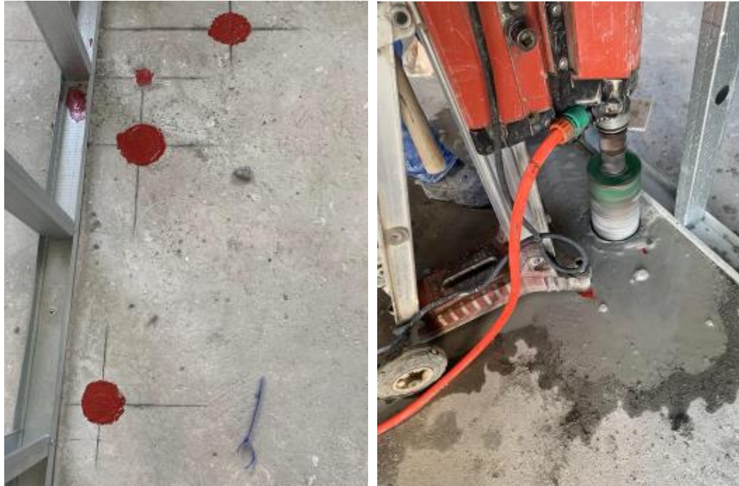
Figura 30 - Marcação com tinta vermelha (esquerda); furos realizados com perfuratriz (direita).
