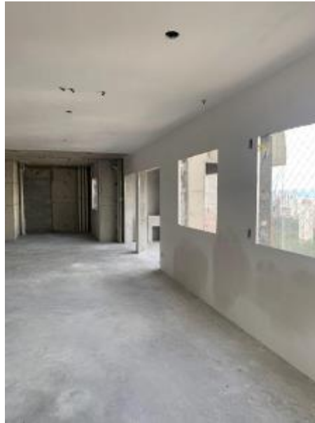
Figura 22 - Forro de Drywall aplicado nos ambientes frios.
