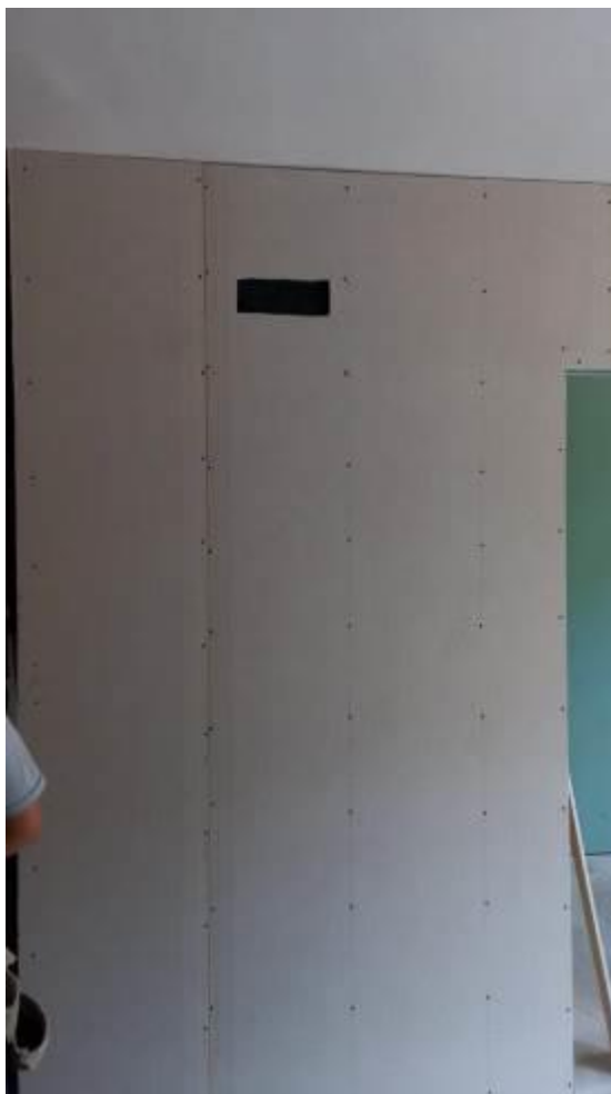
Figura 34 - Placas parafusadas com espaçamento máximo entre parafusos de 15 a 30 cm, e dispostos no mínimo a 1 cm da borda da placa.
