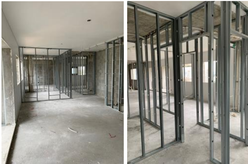
Figura 27 - Estrutura de guias e montantes instaladas no apartamento estudado.
