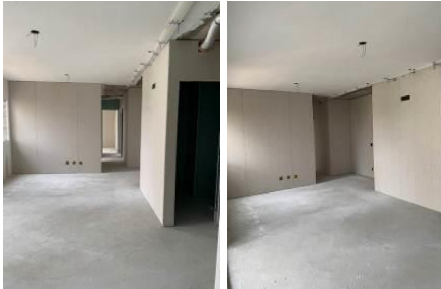
Figura 36 - Etapa de chapeamento finalizada.
