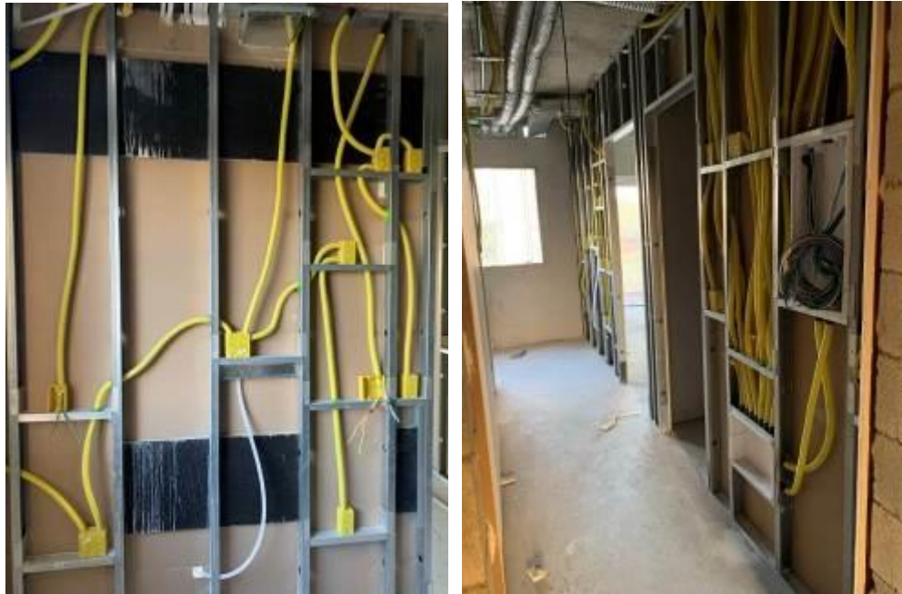
Figura 35 - Primeira etapa de plaqueamento para colocação da lâ de vidro.
