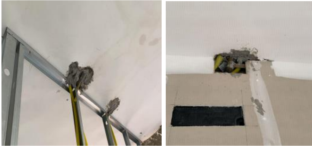
Figuras 41 - Mangueiras distribuídas na etapa de concretagem da laje e arremates de gesso.
