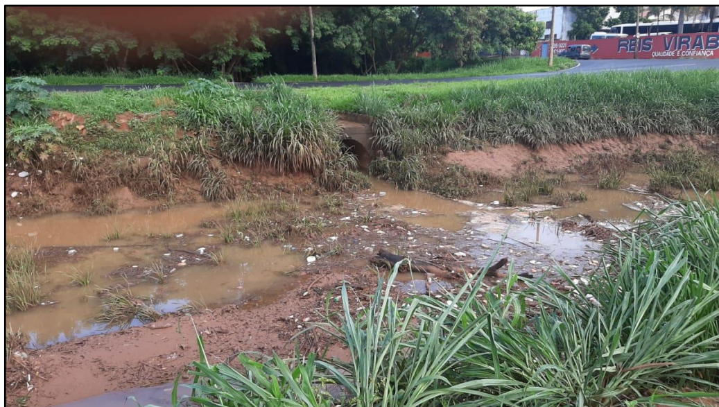
Figura 26 – Trecho assoreado do córrego dos macacos exibindo a presença de lixo e entulho.
