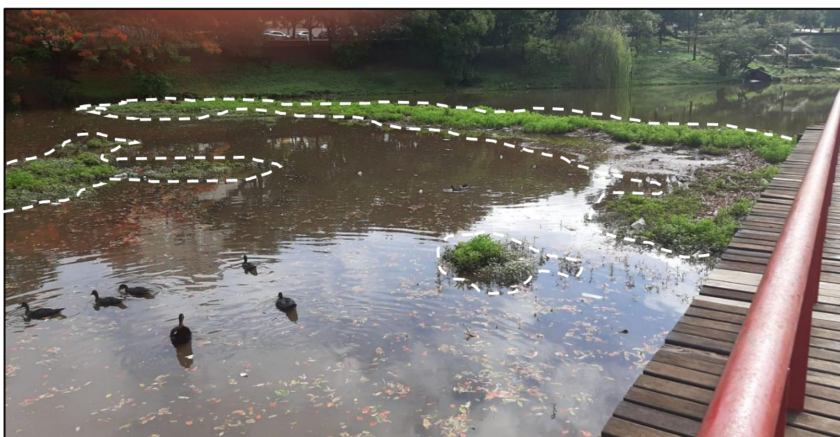
Figura 27 – Reservatório “Lago 2” apresentando banco de areia (tracejado branco), decorrente de assoreamento, já coberto por vegetação.
