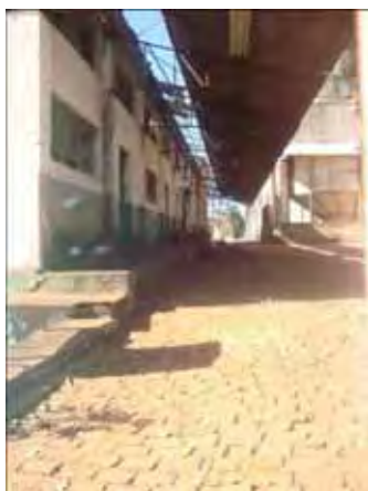
Figura 81. Situação atual do antigo almoxarifado da fábrica. Foto da autora. Data: 29/05/2011.
