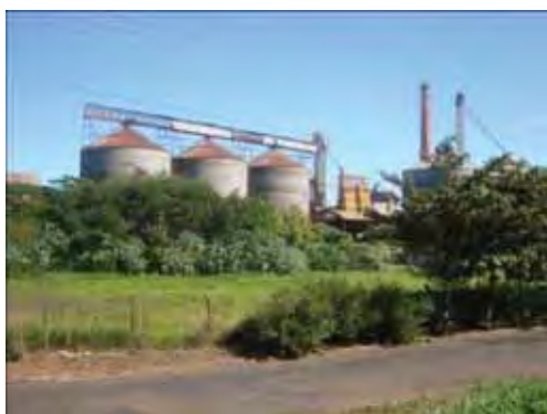
Figura 45 (à esquerda, em cima). Vista do terreno de estudo a partir da rua Antônio de Queiroz. (Foto da autora.Data: 29/05/2011)
