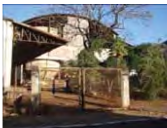
Figura 72. À direita da imagem, galpão onde se fazia a prensagem dos grãos de mamona na antiga indústria . (Foto da autora. Data: 29/05/2011.)
