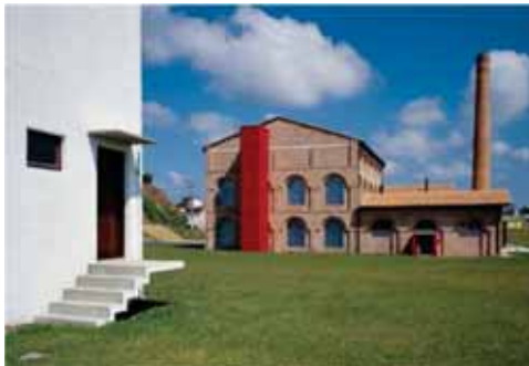
Figura 7. Fachada do Memorial da Imigração Japonesa. Fonte: Escritório Brasil Arquitetura. Disponível em: http://www.brasilarquitectura.com/index2.php . Acesso em: 11/08/2011.
