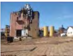
Figura 92. Fachada existente do edifício a ser preservada. (Foto da autora Data: 29/05/2011.)
