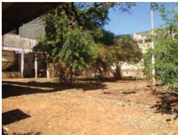
Figura 51 (à esquerda, em cima). Jardim entre os antigos almoxarifado e gerência. Ao fundo, chaminé e prédio que abrigou equipamentos para prensagem de mamona. (Foto da autora. Data: 29/05/2011.)
