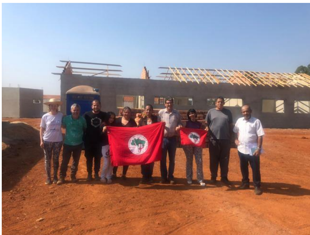
Figura 1: Construção da nova sede da EM Dona Gláucia Aparecida Andrade dentro do assentamento Ipanema
