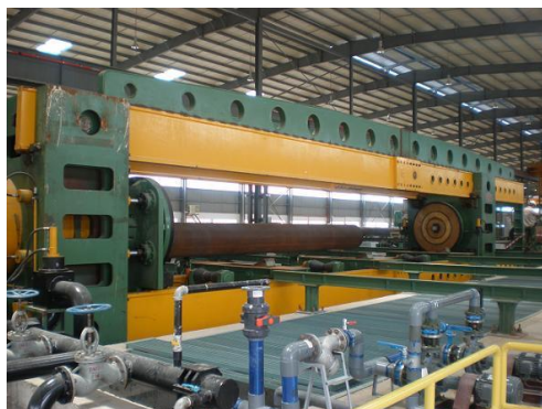
Figura 35 –Equipamento de teste hidrostático
