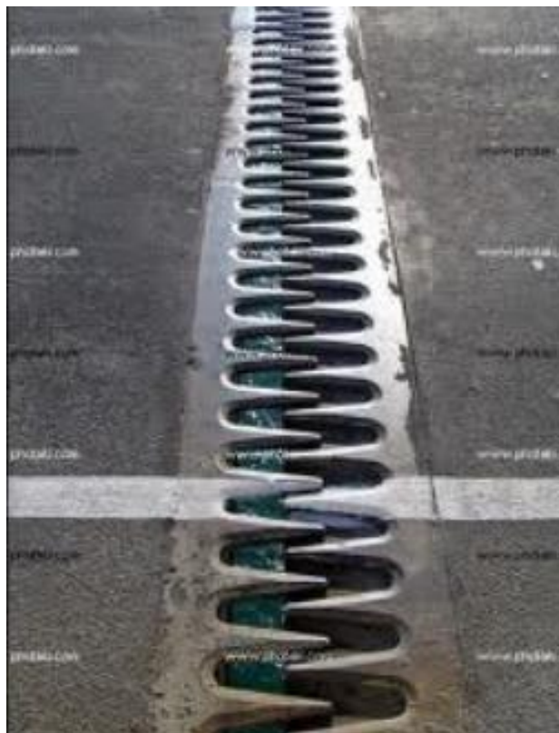
Figura 40 – Junta de dilatação metálica em rodovia
