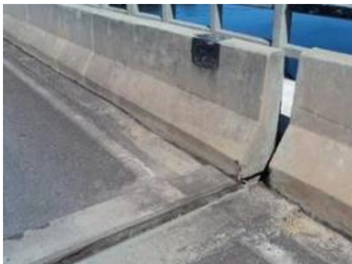
Figura 38 – Junta em tabuleiro de rodovia
