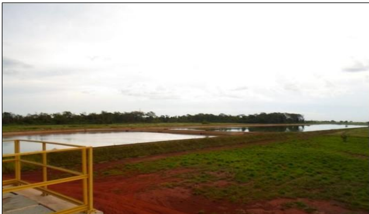
Figura 47 - Lagoas anaeróbia e facultativa
