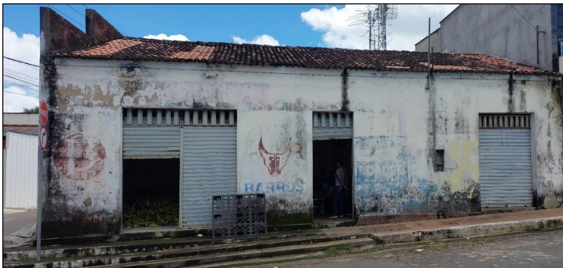
Figura 24 – CRA de Vargem Grande
