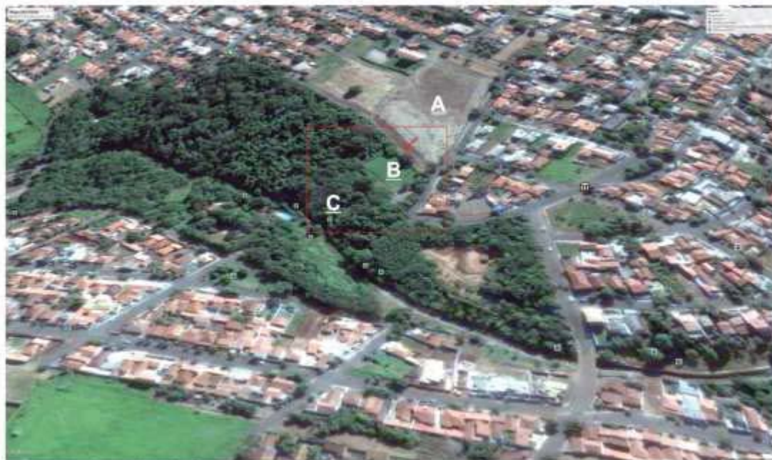
Foto 1 - Vista área da média vertente (A) aonde ocorreu o Movimento de massa, do tipo corrida de terra, para o campo de futebol (B) e APP do Córrego Monjolinho (C)
