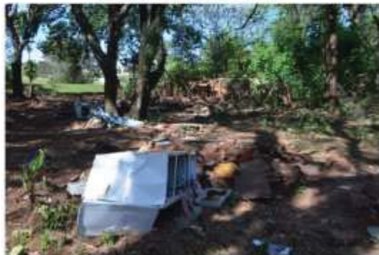
Foto 4 - Habitação totalmente destruída, na área de APP do Monjolinho, pelo transporte de solos e rochas decompostas, da média vertente, por corrida de terra
