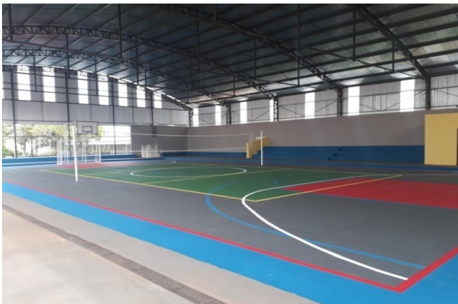
Figura 11 - Quadra de esportes após a reforma e inaugurada em 28/09/2018
