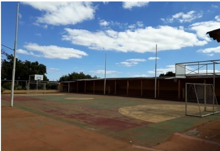
Figura 10 - Quadra de esportes antes da reforma iniciada em agosto de 2017
