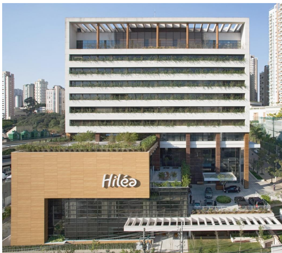
Figura 2 – Fachada principal do Projeto Hiléa.
