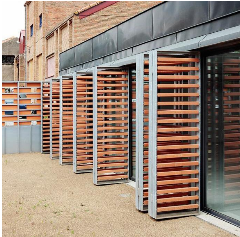
Figura 3 – Brises nas Fachadas de Vidro
