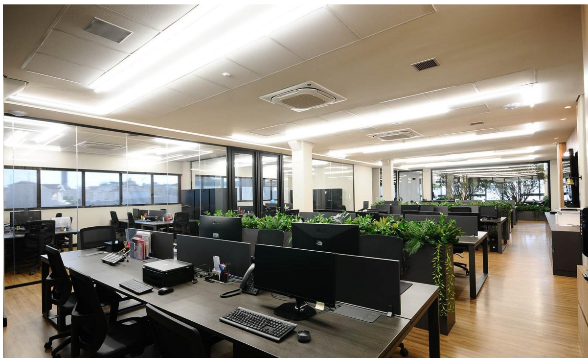
Figuras 4 e 5 – Luminárias em LED utilizadas no empreendimento
