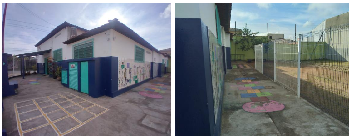
Figura 22: Vista dos espaços externos do PEI Victorino Machado
