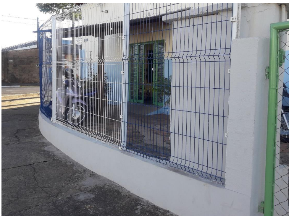
Figura 6: Entrada do Projeto - após melhorias
