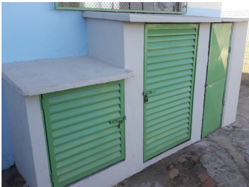
Figura 5: Espaço destinado para o gás e filtro de água - após reforma e pintura
