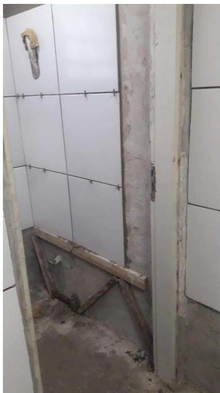
Figura 7: Início da reforma dos banheiros
