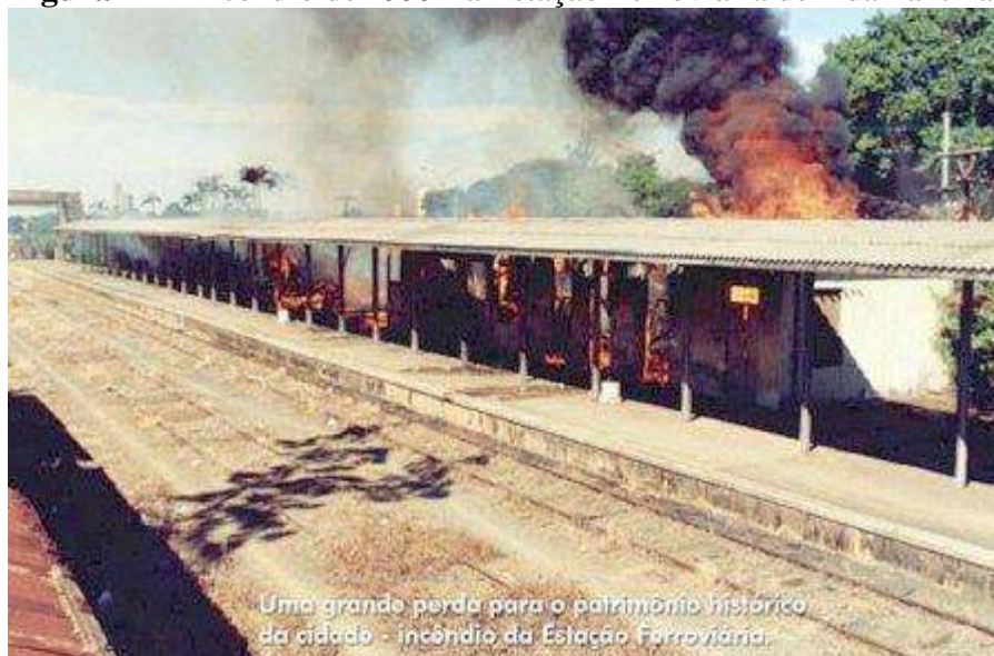
Figura 12 – Incêndio de 1999 na Estação Ferroviária de Adamantina.
