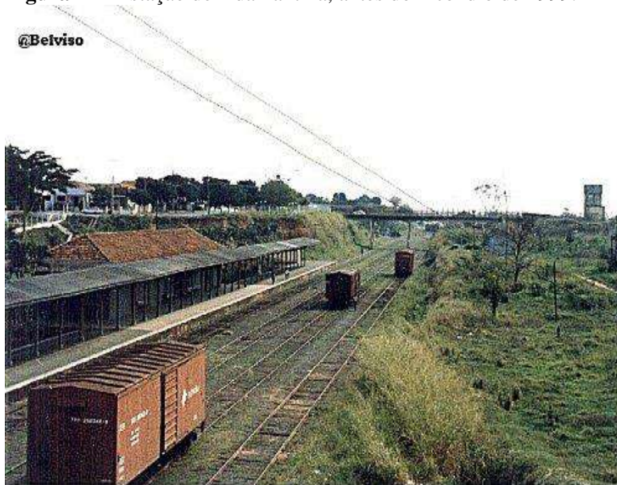
Figura 11 - Estação de Adamantina, antes do incêndio de 1999.
