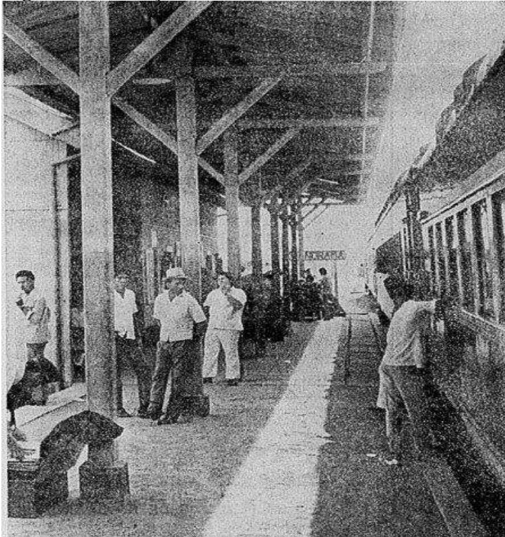
Figura 13 – Estação de Panorama, em madeira, em 1973.
