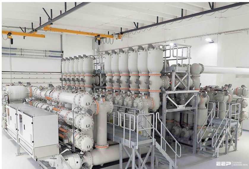
Figura 10. Estrutura geral de uma GIS.
