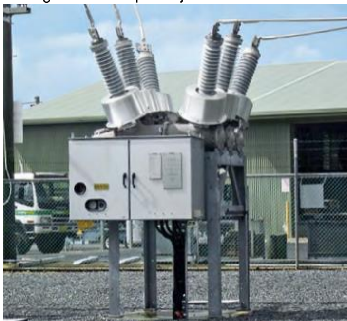
Figura 3. Exemplo disjuntor de alta tensão.
