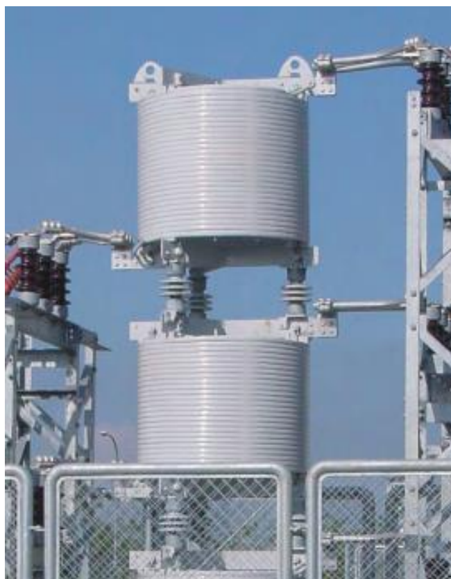
Figura 7. Reator trifásico empilhado limitador de corrente.
