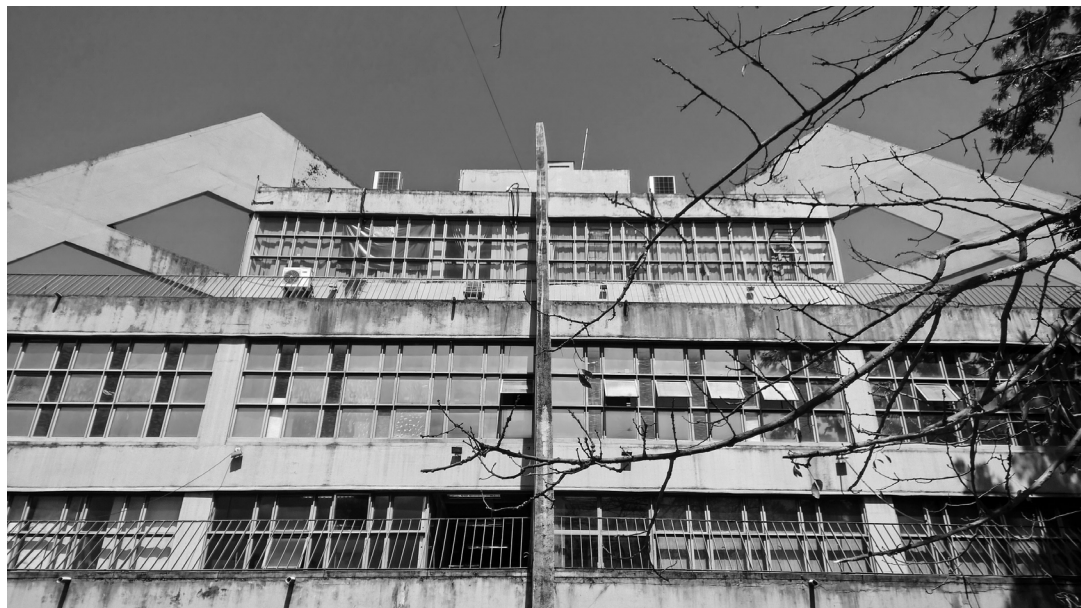
figura 18 - Biblioteca Municipal de São José do Rio Preto.
