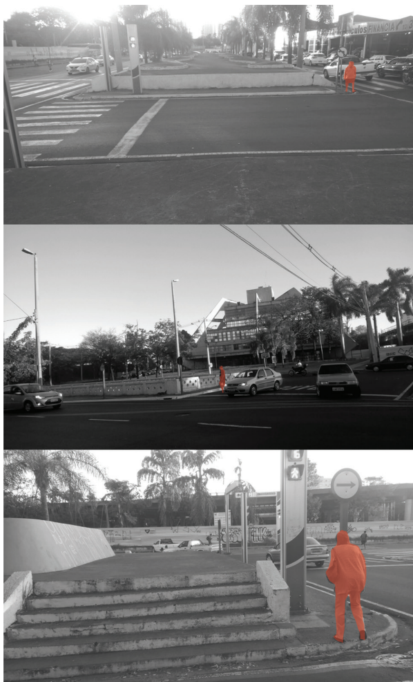
figura 24 - Travessias dificultadas ao longo do setor 'A'.
