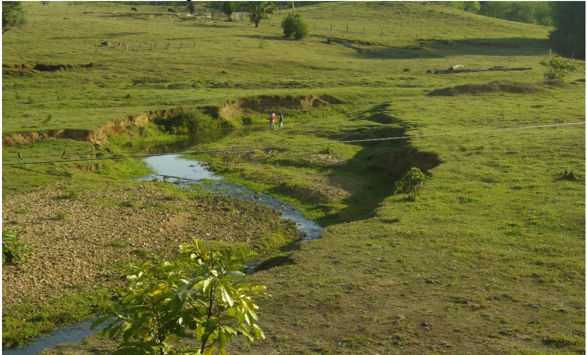
Figura 13 – Foto de trecho do Córrego Hermes com sinais de degradação, como ausência de vegetação florestal, assoreamento do curso e alteração no talude, no momento do diagnóstico ambiental em Colorado do Oeste-RO.
