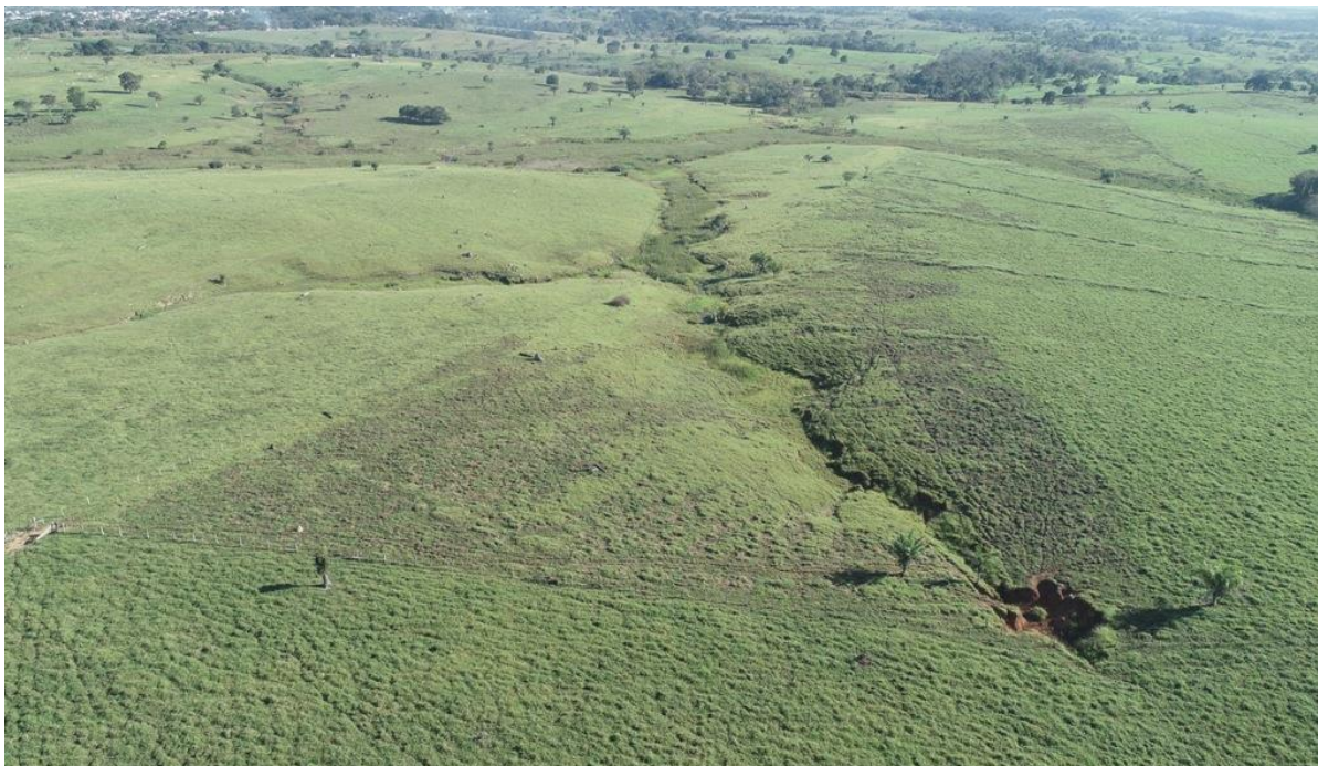
Figura 35 – Imagem aérea de áreas que comprovam a não efetividade da recuperação das matas ciliares do Córrego Hermes, Colorado do Oeste-RO.
