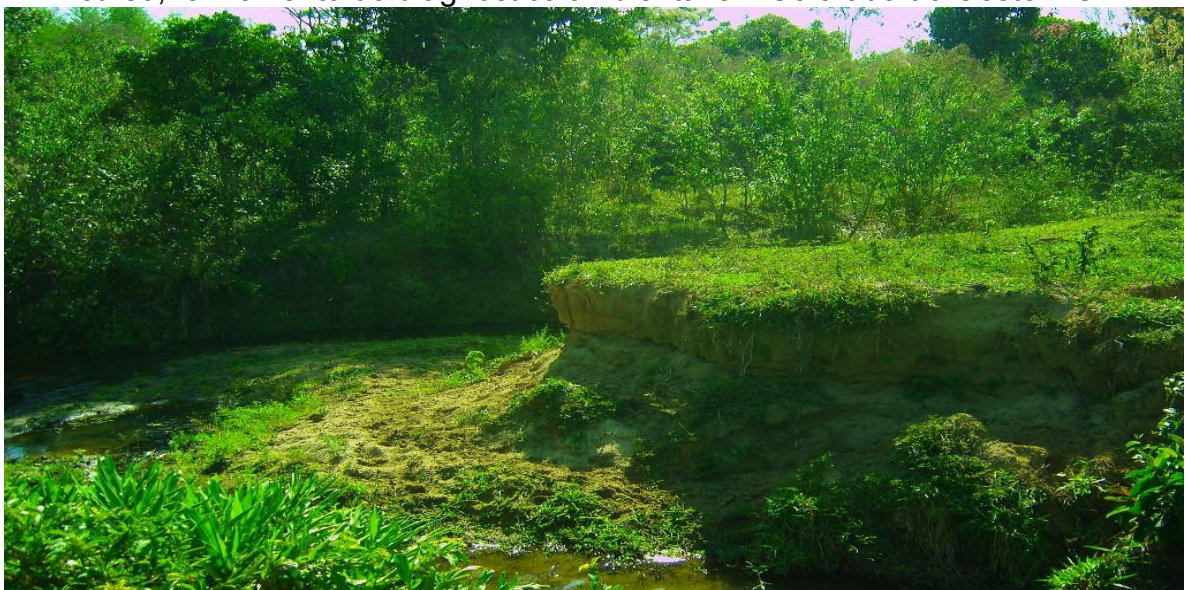
Figura 9 – Foto de trecho do Córrego Hermes com sinais de degradação, como ausência de vegetação florestal, assoreamento do curso e alteração no talude do curso, no momento do diagnóstico ambiental em Colorado do Oeste-RO.
