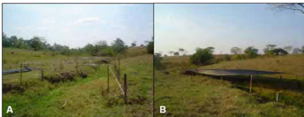
Figura 2. Montagem da cobertura experimental no Córrego do Tatu. A – Pontaletes e armação de arame; B – trecho coberto com as telas de sombreamento (tratamento).
