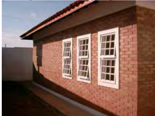
Figura 14 – Exemplo de alvenaria com tijolos aparentes de solo-cimento
