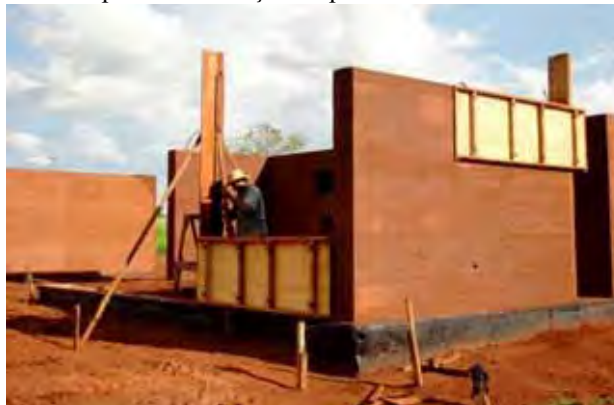
Figura 15 – Exemplo de construção de paredes monolíticas de solo-cimento
