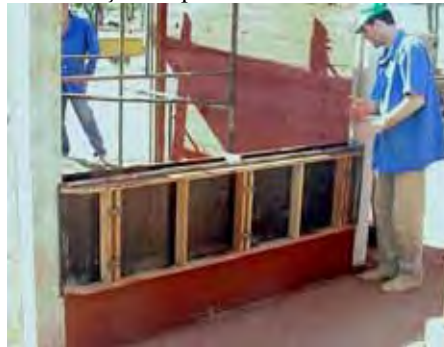
Figura 16 – Execução de parede monolítica de solo-cimento
