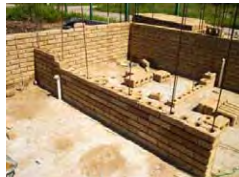
Figura 12 – Alvenaria com tijolos de encaixe de solo-cimento
