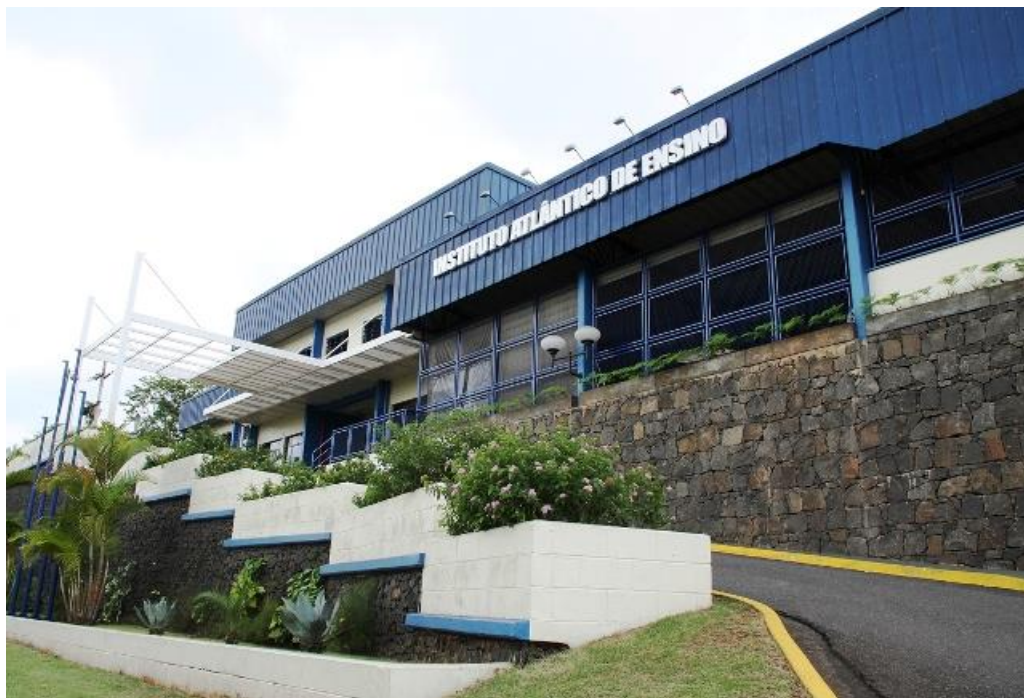
Figura 5: Fachada do Instituto.
