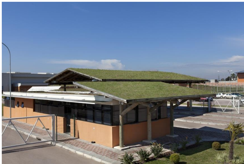
Figura 11: Telhado verde extensivo
