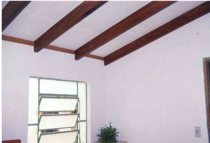
Figura 2.8 – Piso em microconcreto e madeira. Fonte: SORIANO (2001)
