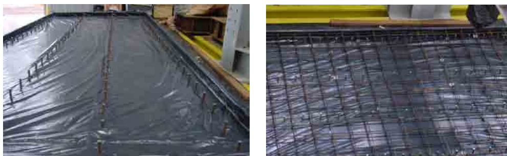
Figura 6.10 – Preparação da forma para concretagem
