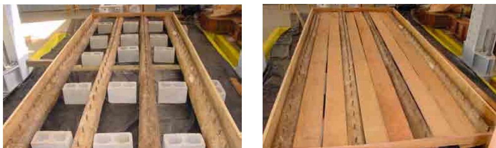
Figura 6.9 – Montagem da forma da laje
