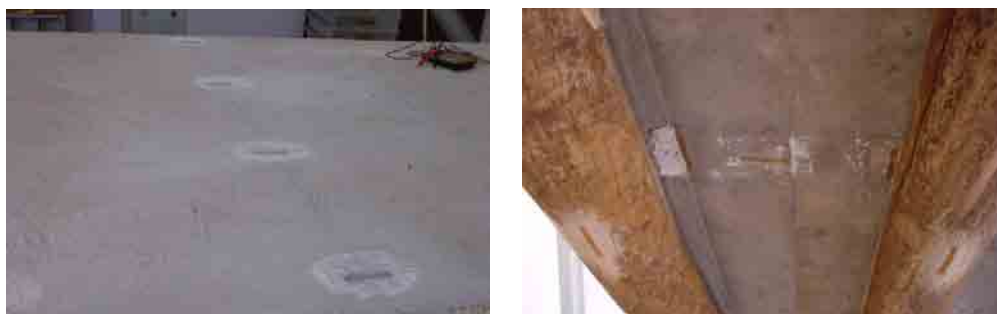
Figura 6.14 – Extensômetros no tabuleiro misto de madeira-concreto
