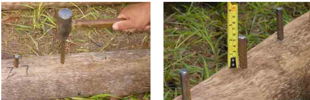
Figura 6.5 – Cravação e verificação da altura de ancoragem
