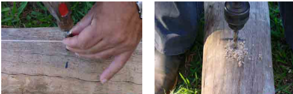
Figura 6.4 – Marcação e pré-furação das vigas de madeira
