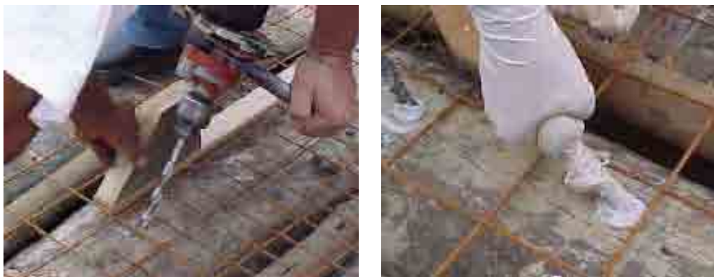
Figura 2.14 – Detalhe da colagem dos conectores. Fonte: PIGOZZO (2004)
