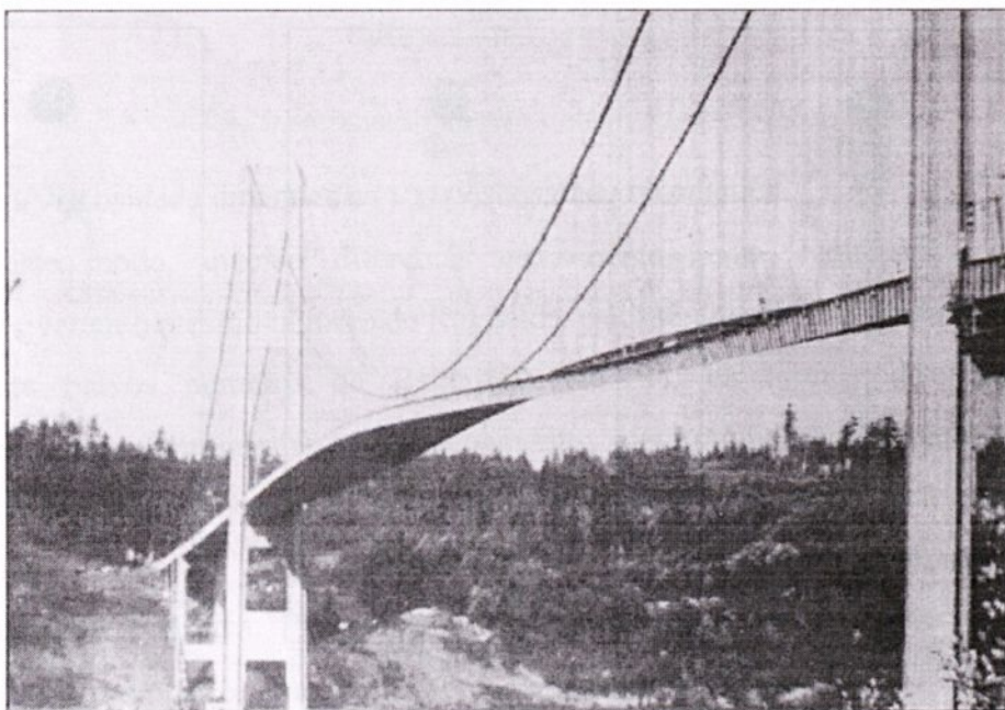
Figura 2.4 – Ponte do Estreito de Tacoma momentos antes de sua destruição.
