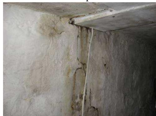
Figura 18. Efeito da umidade em túnel de indústria de vinho.
