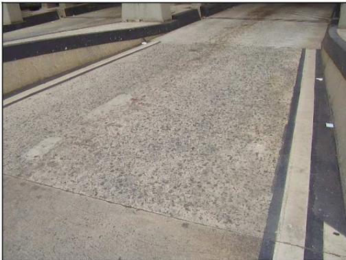
Figura 13. Efeito da abrasão em pisos industriais.
