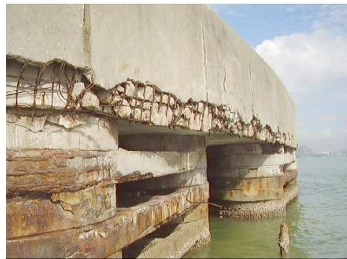
Figura 16. Efeito da deterioração por Cloretos em estrutura próxima ao mar.
