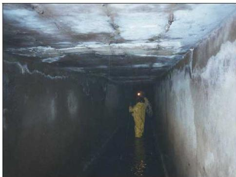
Figura 17. Efeito do contato com a água em galerias pluviais.
