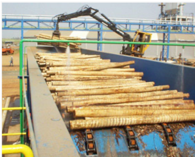
Figura 13 – Esteira para manuseio de toras de madeira até as mesas de picagem
