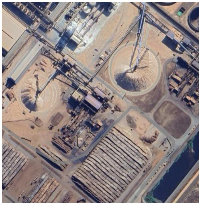
Figura 17 - Pátio de madeira visto de cima
