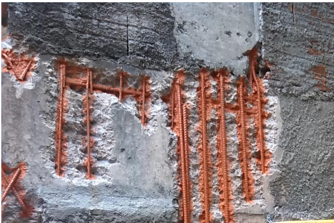
Fotografia 13 - Aplicação de proteção nas armaduras
