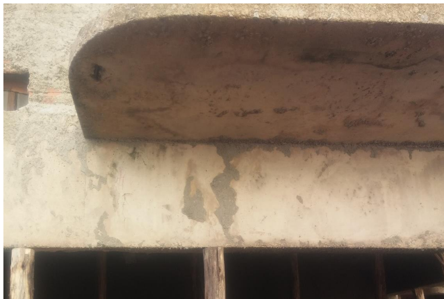
Fotografia 11 - Limpeza do concreto
