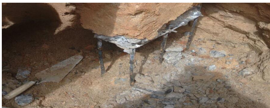
Fotografia 9 - Escavação da base do pilar sem fundação
