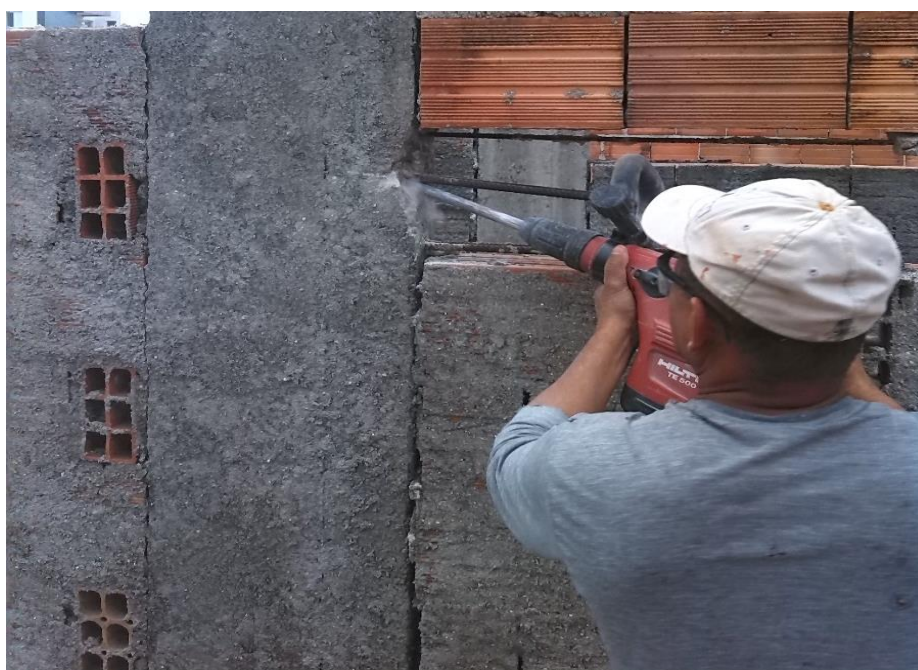
Fotografia 12 - Corte de concreto para exposição de armadura corroída
