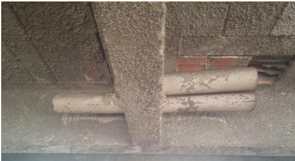
Fotografia 2 - Tubos de PVC atravessando viga
