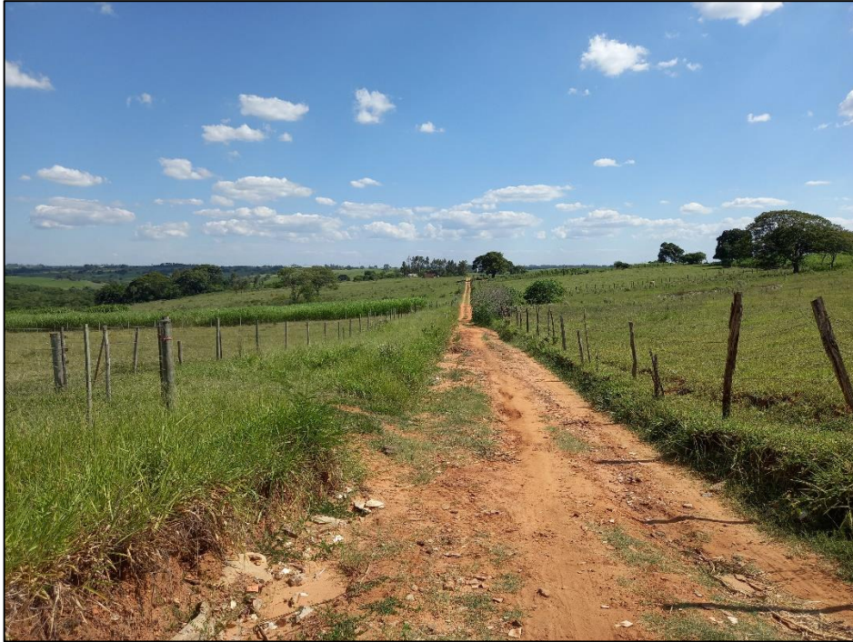
Figura 2 – Estrada com processo erosivo acelerado, leito encaixado
