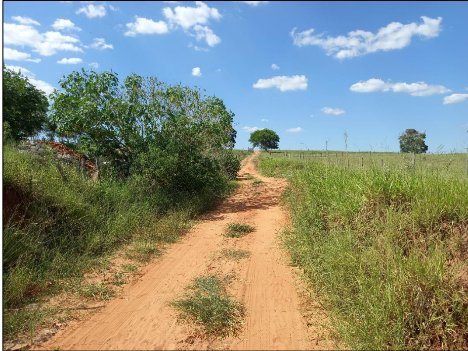
Figura 6 – Estrada encaixada com barrancos laterais e presença de vegetação arbustiva.
