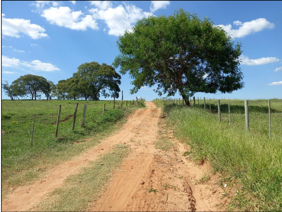
Figura 4 – Estruturas ineficientes com formação de ravinas, leito encaixado
