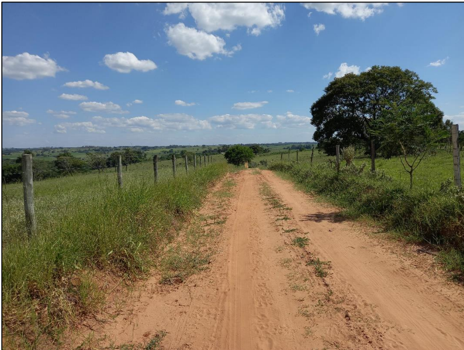
Figura 3 – Estrada com processo erosivo acelerado, leito encaixado.
