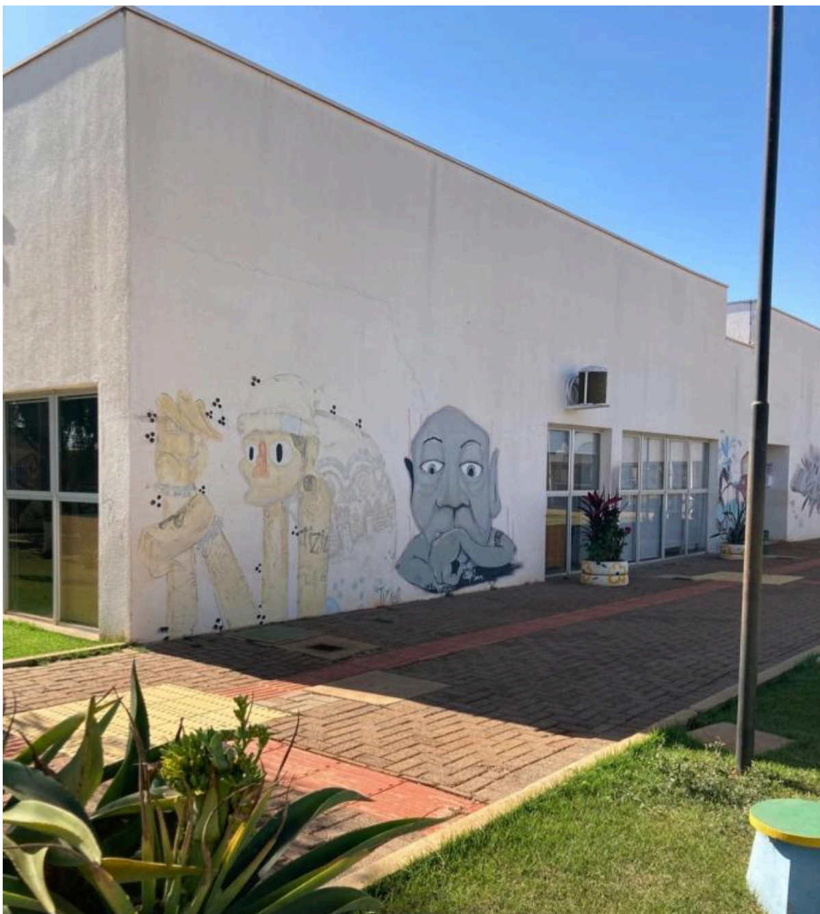
Foto 1 - Fachada da Casa da Juventude de Sertãozinho/SP.
