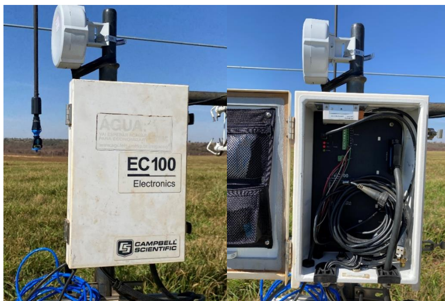
Figura 9 - Montagem do EC100.
