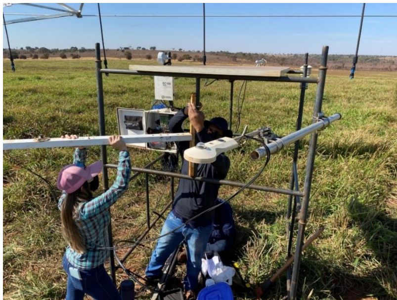
Figura 6 - Montagem da torre e instalação dos instrumentos de leituras micrometeorológicas.
