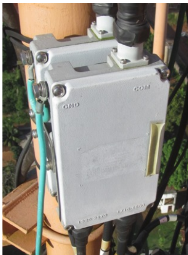
Figura 12 – Diplexer - Dispositivo passivo que combina ou separa bandas de frequências distintas, representado na imagem o equipamento que opera em 1020-2170Hz e 1710-1880Hz Permitindo o uso compartilhado de antenas (multi-bandas) e cabos.
