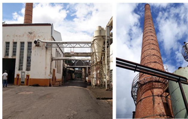
P2: "Essa aqui era a caldeira; o apito ficava ali em cima, e aqui era a chaminé." (Francisco, 2023)
