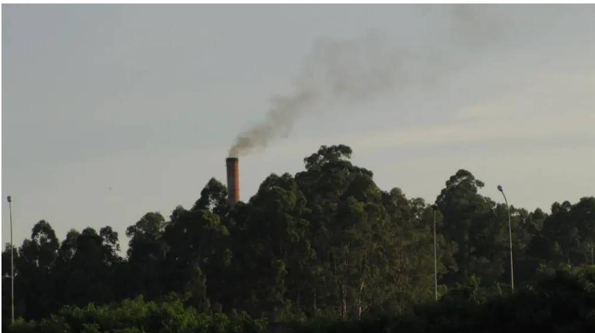
Figura 36 — Vista da Chaminé pelo bairro. Fonte: Acervo pessoal (2024)
