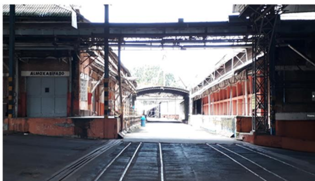
P5: "A ferrovia Paulista vinha, largava o vagão vazio aqui e pegava o cheio, depois fazia a manobra. Esta aqui é chamada bitola estreita, e esta outra, bitola larga" (Francisco, 2023)
