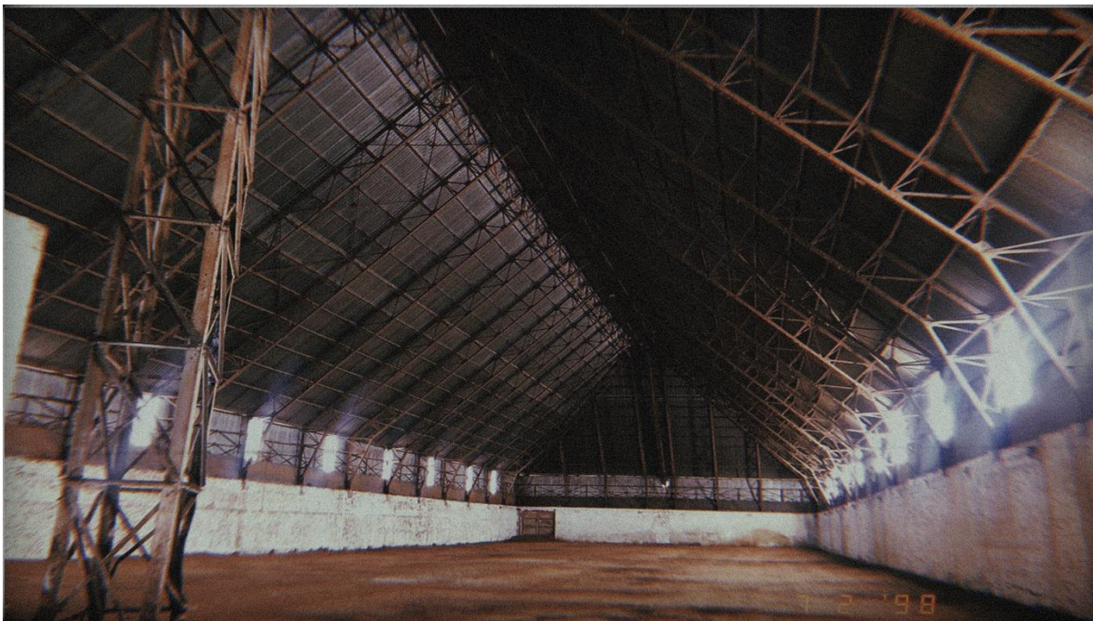
Figura 39 — Caminhar em Ruínas I. Fonte: Acervo pessoal (2024)
