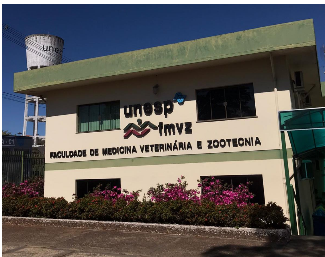
Figura 1. Vista da fachada da Faculdade de Medicina Veterinária e Zootecnia (FMVZ), Unesp Botucatu/SP.
