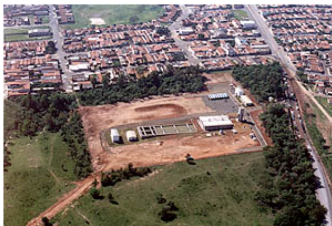
Figura 18 - Estação de tratamento de esgoto Jardim das Flores
