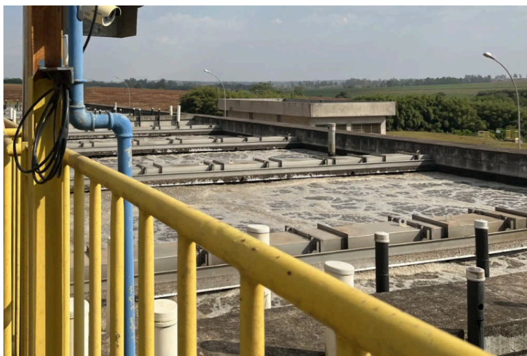
Figura 19 - Estação de tratamento de esgoto Jardim das Flores
