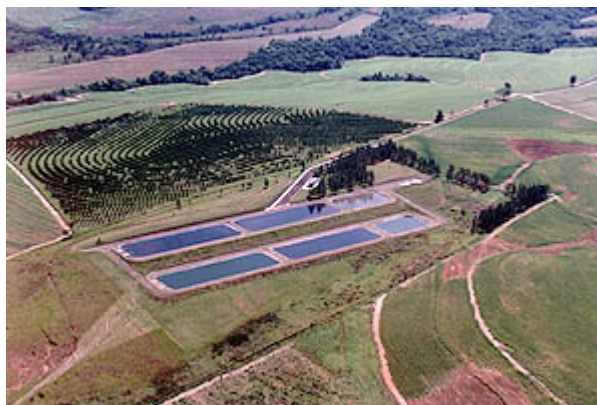
Figura 13 - Estação de tratamento de esgoto de Ajapi
