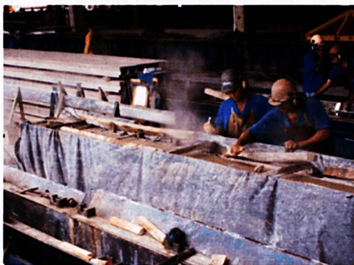
Figura 42 – Empresa de pré-moldados que utiliza a cura térmica.
