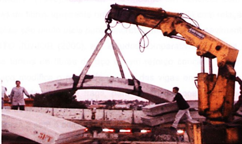
Figura 27 – Exemplo de aduelas utilizado em túneis, confeccionadas com fibras de aço
