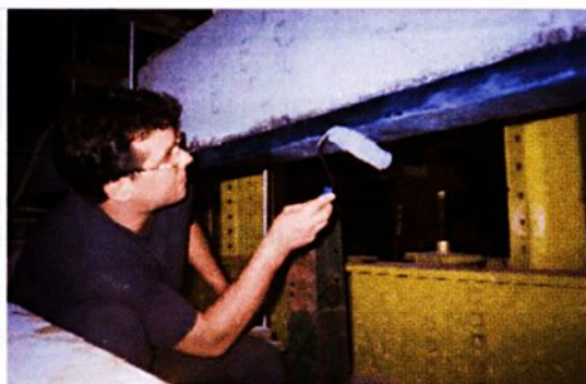
Figura 11 – Reforço externo, aplicação de tecido de fibra de carbono
