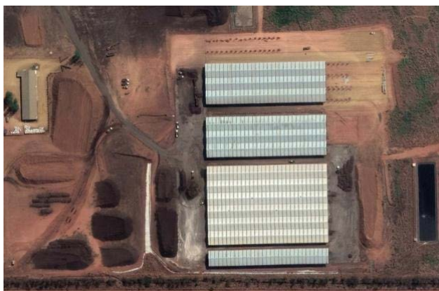
Figura 9 – Setor de compostagem - Granja Mantiqueira em Primavera do Leste – MT. Fonte: Google Earth
