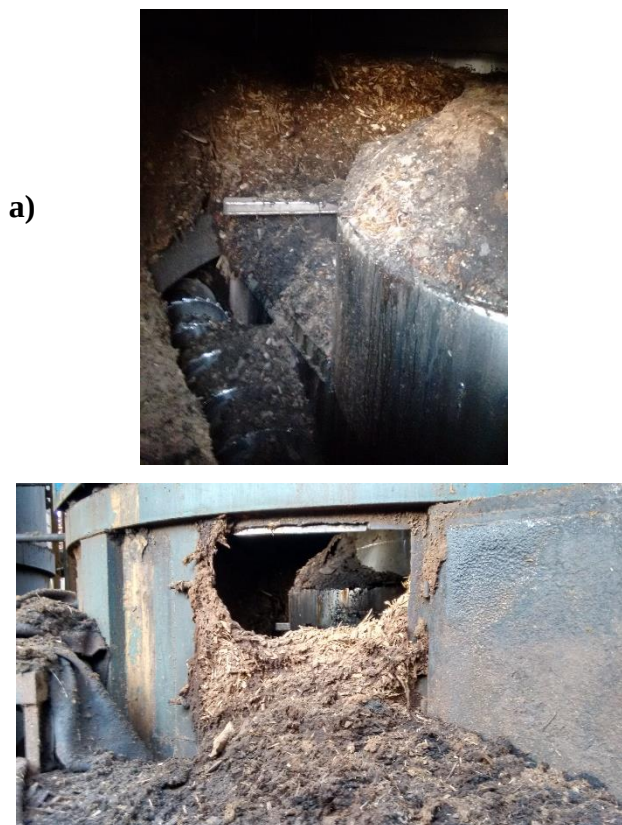
Figura 36: Biomassa. a) Registro do interior do Silo durante período de inspeção. B) Detalhe da composição da biomassa.
