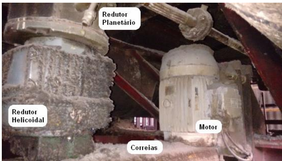
Figura 35: Conjunto motriz do Rotor de um silo.
