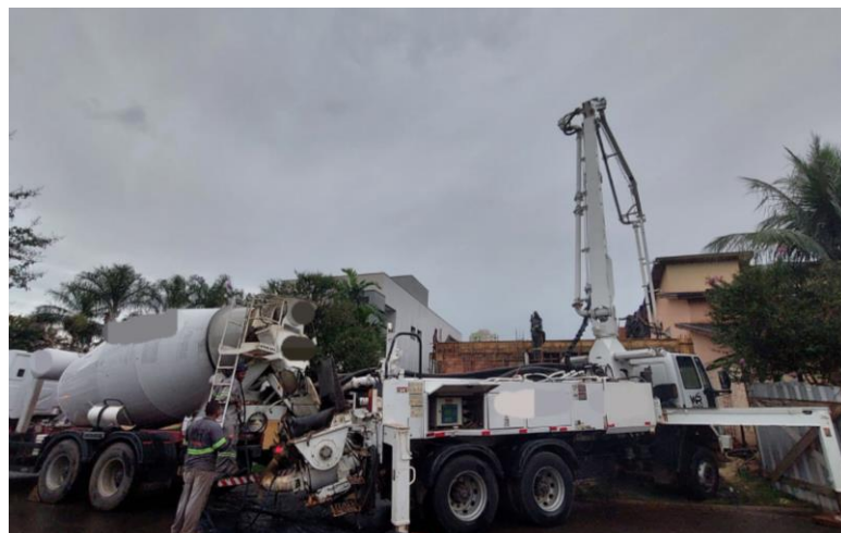
Figura 17: Concretagem com bomba lança
