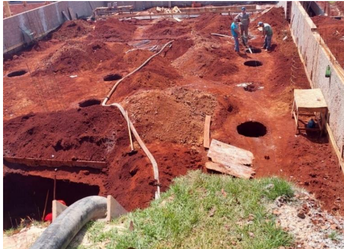
Figura 16: Concretagem com bomba estacionária
