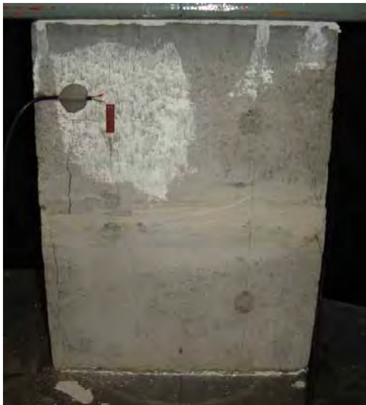
Figura 5.32 - Fissuração nos prismas PR2-A02-G1.
