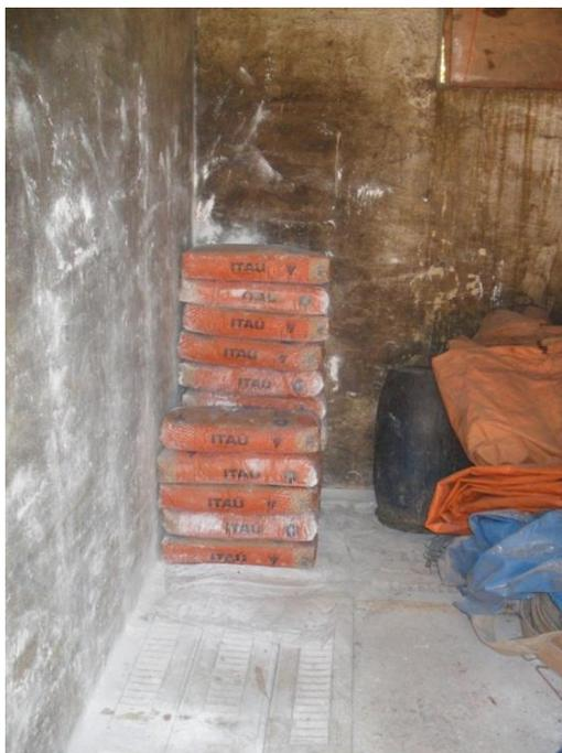
**Figura 38: Armazenagem de Cal**
