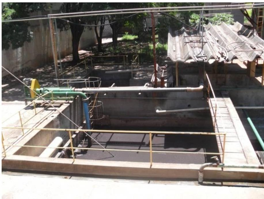
**Figura 29: Caixa de recebimento de efluente para tratamento**
