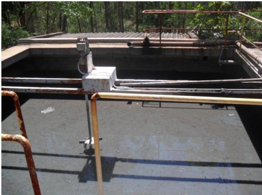
**Figura 30: Caixa que ocorre adição de Cal e P.A.C.**
