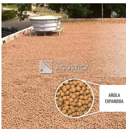
Figura 16 – Aplicação da camada de drenagem em uma laje.
