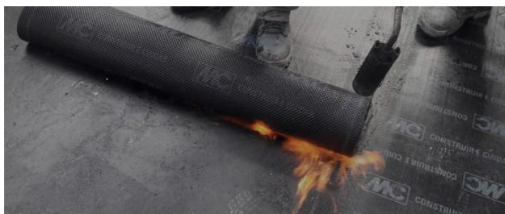
Figura 15 – Aplicação da massa asfáltica com o auxílio de um maçarico.
