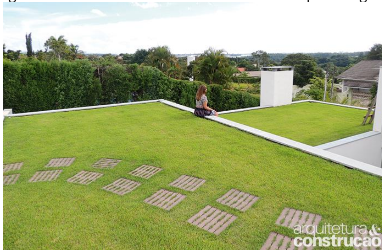
Figura 8 – Telhado verde contendo uma única espécie vegetal.
