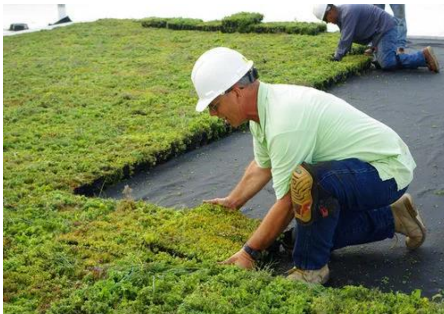
Figura 14 – Aplicação de um telhado verde modular
