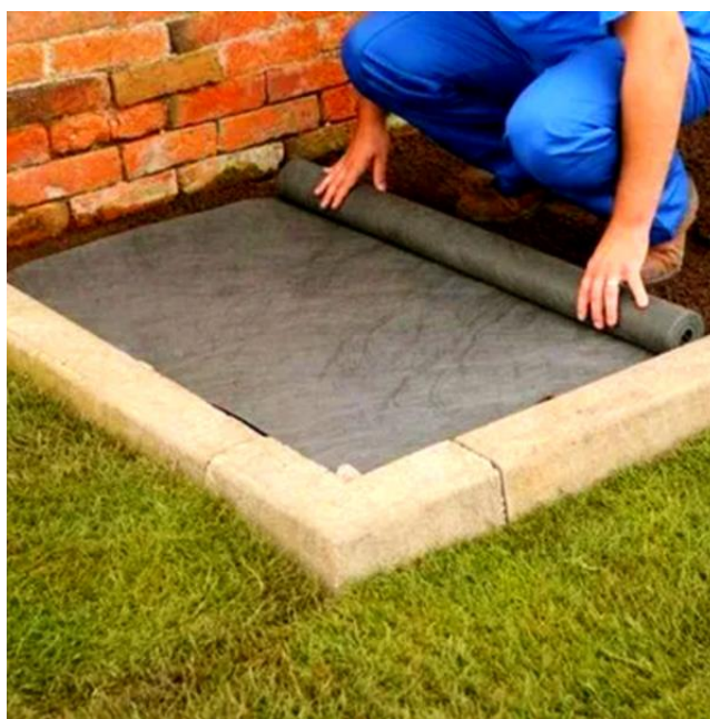
Figura 17 – Aplicação de uma manta geotêxtil
