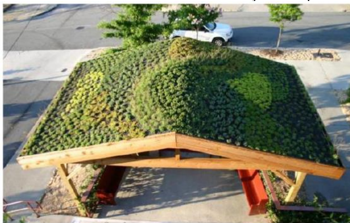
Figura 7 – Telhado verde contendo uma associação de espécies vegetais.
